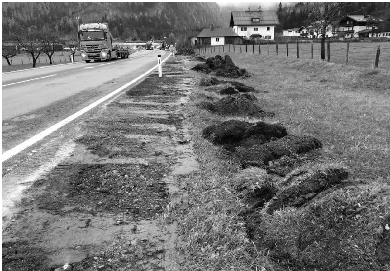
Abb. 35. „Abziehen“ des Bankettbereiches zum besseren Abfluss des Fahrbahnwassers und zur Schaffung eines (vorübergehend) pflegefreien Fahrbahnrandes (St. Martin bei Lofer, Pinzgau).
